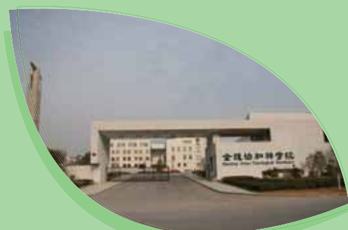
正門 Main entrance
